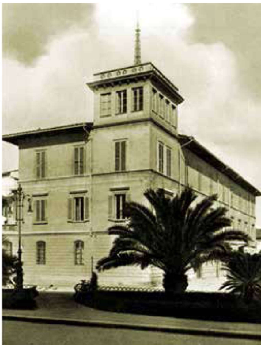
Fig. 9. Un'immagine prebellica di Palazzo Matteucci, sede dell'Istituto di Fisica, con la torre sulla quale era impiantata l'antenna delle telecomunicazioni. L'ala dell'edificio con la torre fu fatta saltare dai tedeschi, mentre, grazie al coraggio di Marianina Ciccone, si salvò il resto del fabbricato.
