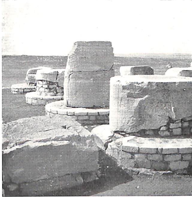
4. Soleb. - Ipostila, settore Sud. I tamburi inferiori della colonnata inalzati nei nuovi sostegni.
