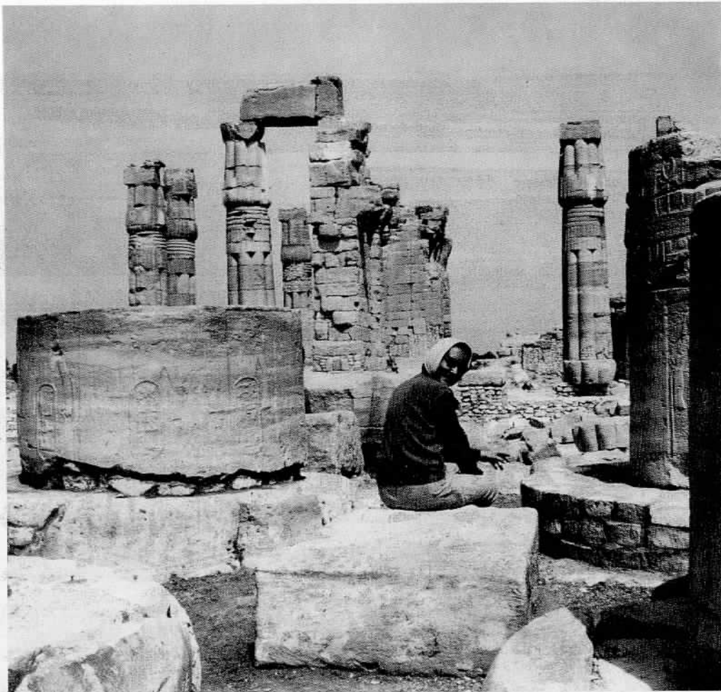
Fig. 129. Temple: Michela Schiff Giorgini dans les ruines de la salle hypostyle, lors des travaux de restauration du secteur IV.
