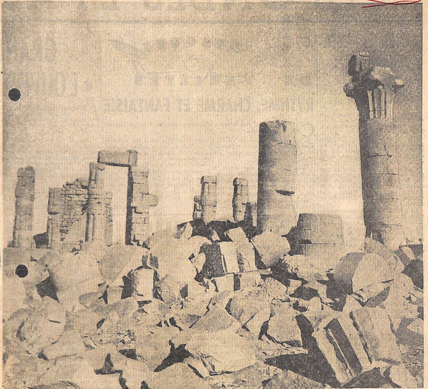
Une vue générale des ruines.
